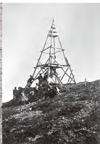
三角測量の檣 白馬岳山頂 1874（明治7）年に内務省に地理寮が設けられて以後、政府による地形図作りのための国内全土を対象とした本格的な三角測量が行われました。測量の基点に見通しのきく場所が選ばれ、土中に埋めた花崗岩製の標石のうえに木製の檣を建て、計測器をすえて観測が行われました。
