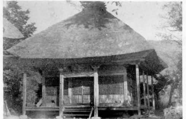
盛蓮寺観音堂（重要文化財）もとは現在地より北の山寺というところにあつたものが、戦国時代に現在の場所に移されたといわれています。
