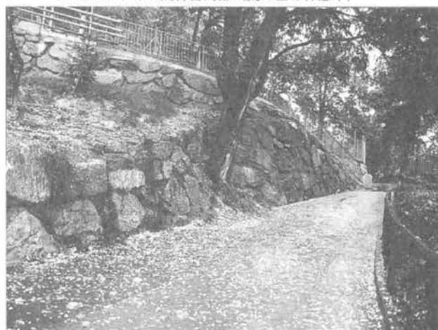
石と木を活用した歩道
