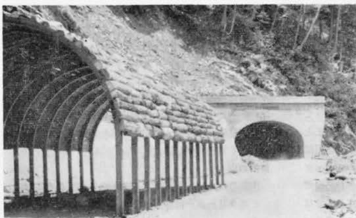
黒部へのトンネル入口
