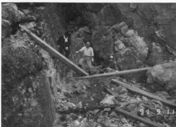
修復中の棧道
