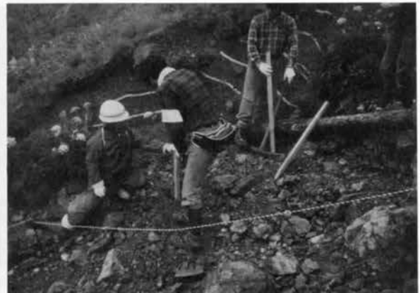
登山道の土留め工事
