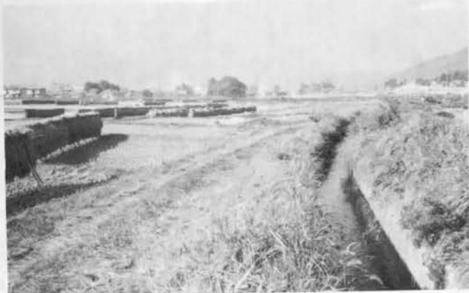
館之内長田地籍付近の横堰 左側は水路管理道、微地形に順応した屈曲流路が目目される
