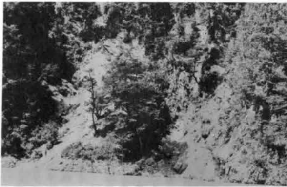
水位変動によって生じた小崩壊地
