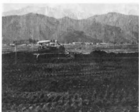
ブルドーザーで表土を除去する
