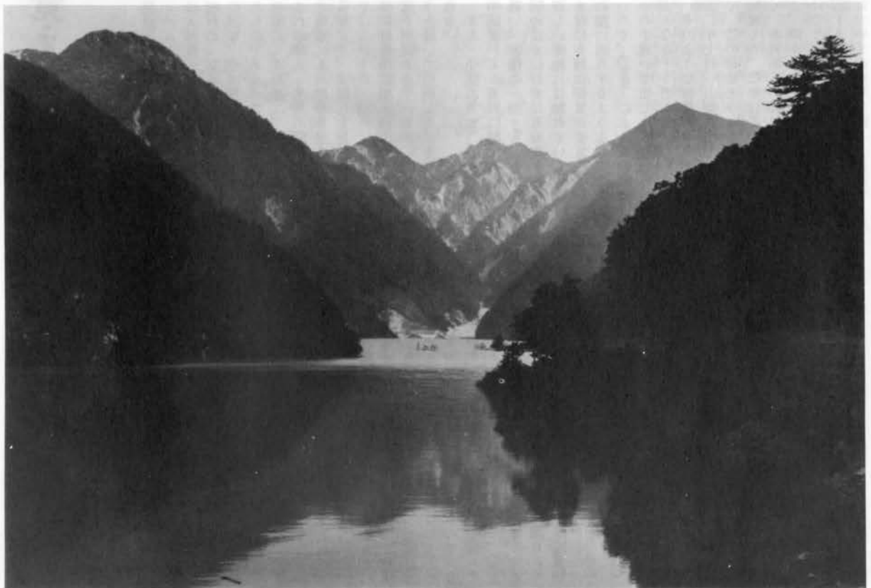
湛水された高瀬ダム (東沢付近より)
