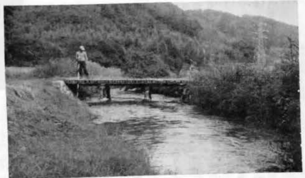
農具川 飯島地籍 整備後、鉄橋になり、 川の側壁はコンクリート製になる 提供 大門市土地改良区
