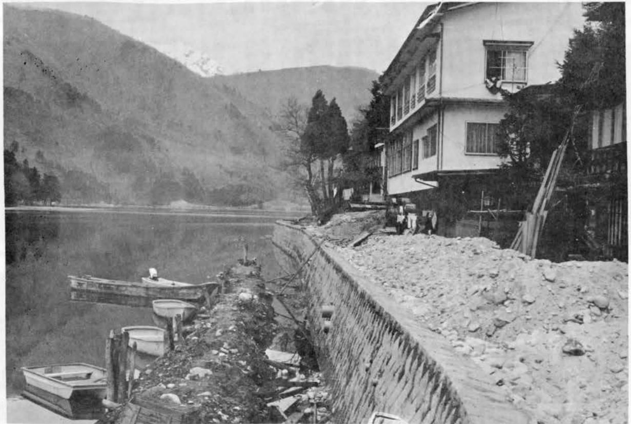
歩道工事中の木崎湖岸 山崎にて
