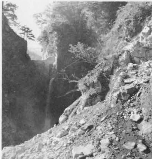
岩盤の爆破作業が進む 不動の滝、付近
