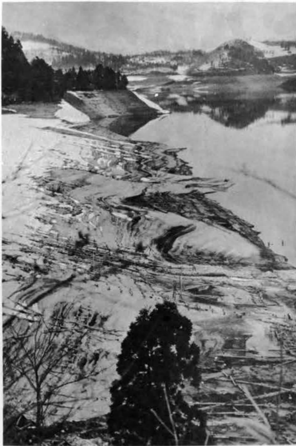
図1 水位の下がった青木湖 (青木湖中綱湖被害対策委員会提供)
