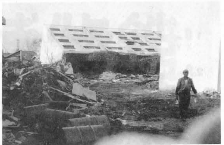
第3図 新潟市川岸町の県営アパートの倒壊(平林)
