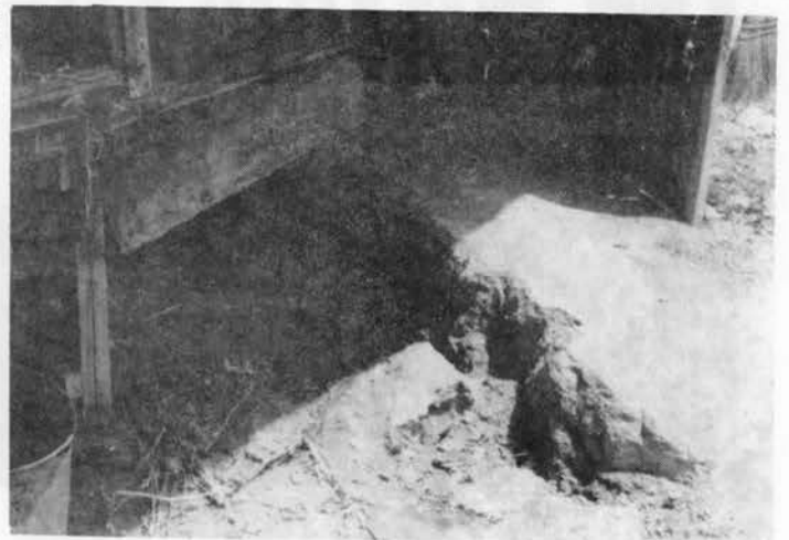
第2図 松代 加賀井の地割れ、西側30cm落ち 延長50m 20cm開口(平林)
