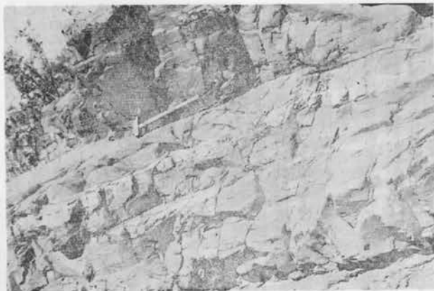
島々駅北の梓川河床中の粘板岩の岩壁
